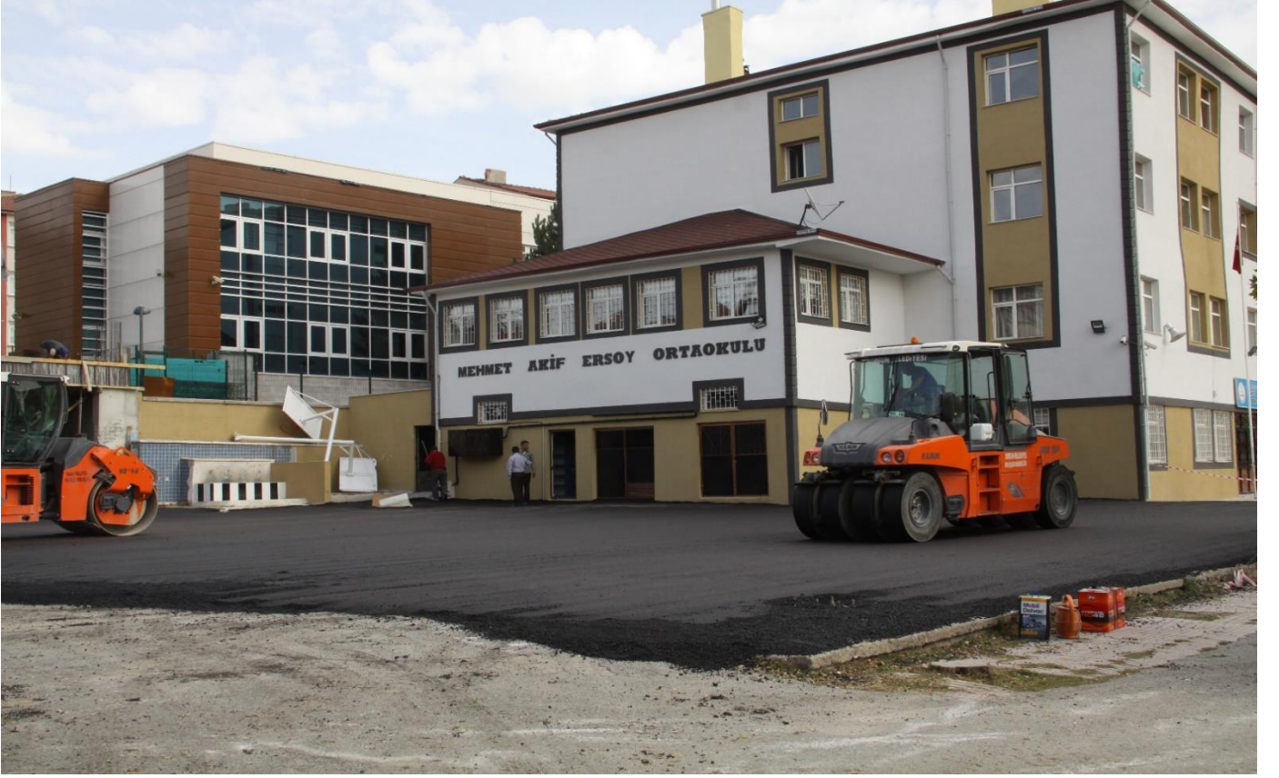
Milli Eğitime bağlı okullarımıza yapılan asfalt çalışmaları
